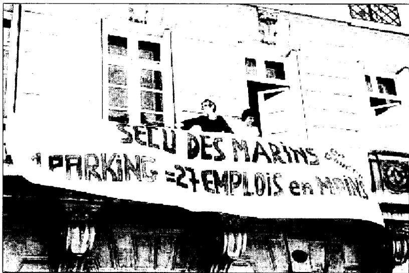
Le bâtiment de l'Enim à Bordeaux doit laisser place à un parking dans le cadre de la réalisation d'une nouvelle ligne de tramway.
